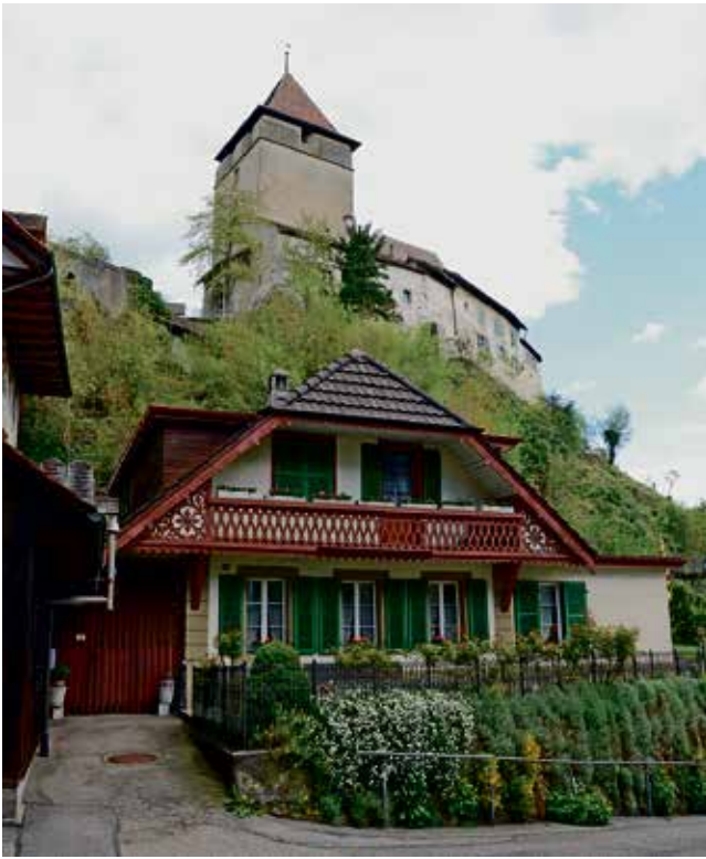
Abb. 7: Zustand der Hafnereiliegenschaft Rütshelengasse 23 im Jahr 2016. Links am Bildrand befand sich bis 1843 das Rütshelentor (Foto A. Heege)
