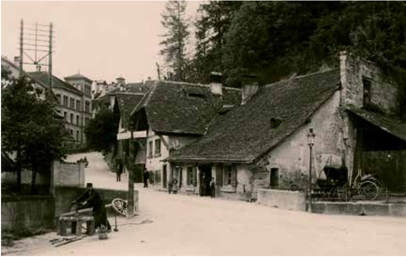
Abb. 5: Gebäudegruppe am unteren Ende der Rütchelengasse, um 1898. In dem Haus mit dem halb abgewalmten Dach befand sich vor 1795 die Werkstatt von Emanuel Aeschlimann. Rechts davon ist das ehemalige, öffentliche Rütchelenwaschhaus zu sehen. Rechts, etwas schräg zurückversetzt, schloss sich einst das Werkhaus der Zimmerleute an
