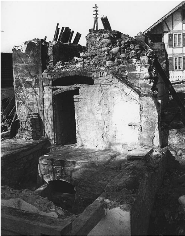
Abb. 7 Heimberg, Bahnhofstr. 4, Töpferei Hänni. Abbruch des Brennofens 1951.
