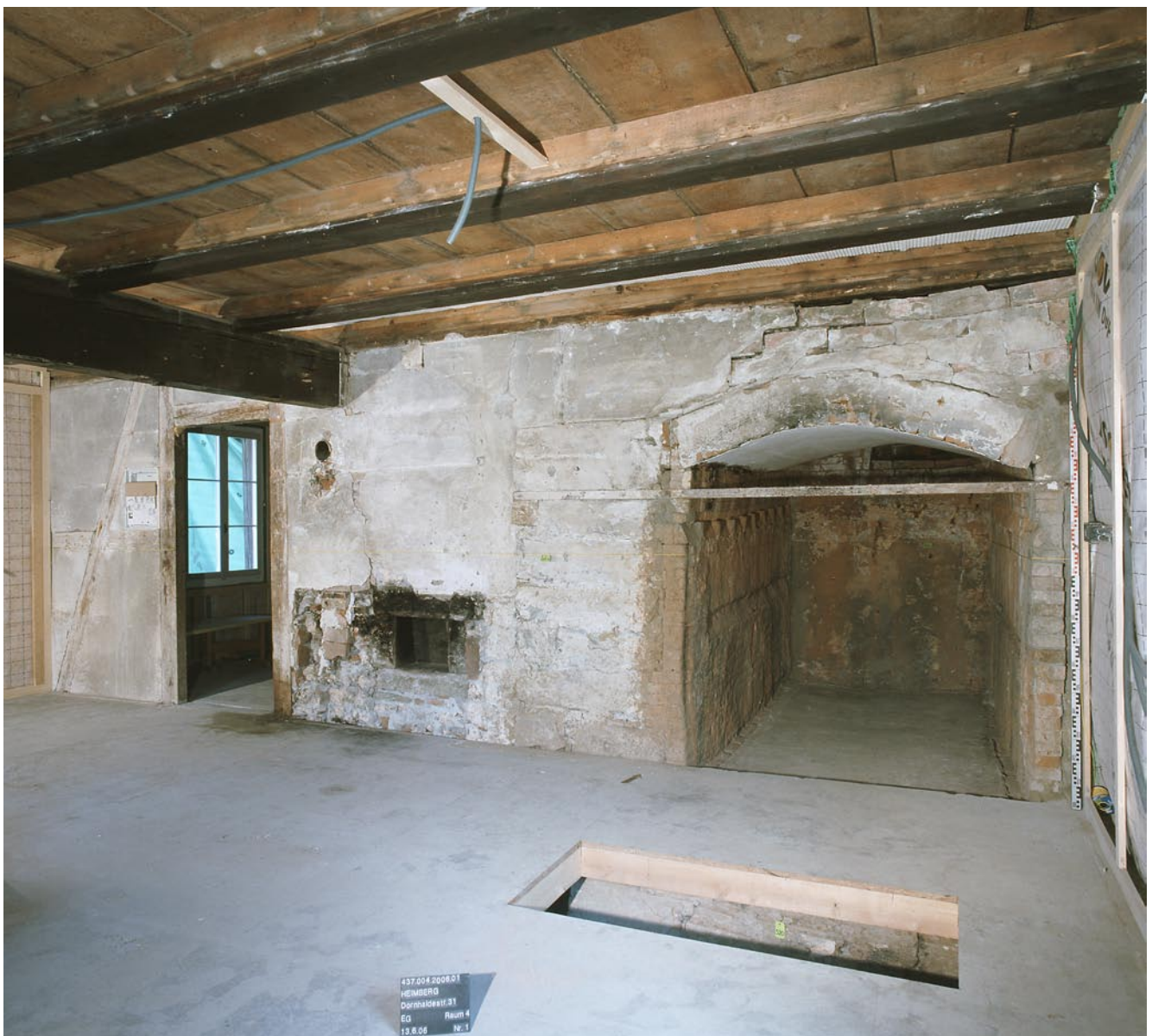
Abb. 12 Heimberg, Dornhaldestr. 31, 2006, Erdgeschoss. Ansicht des Brennofens und der Trennwand zur Gesellenkammer von Süden.
