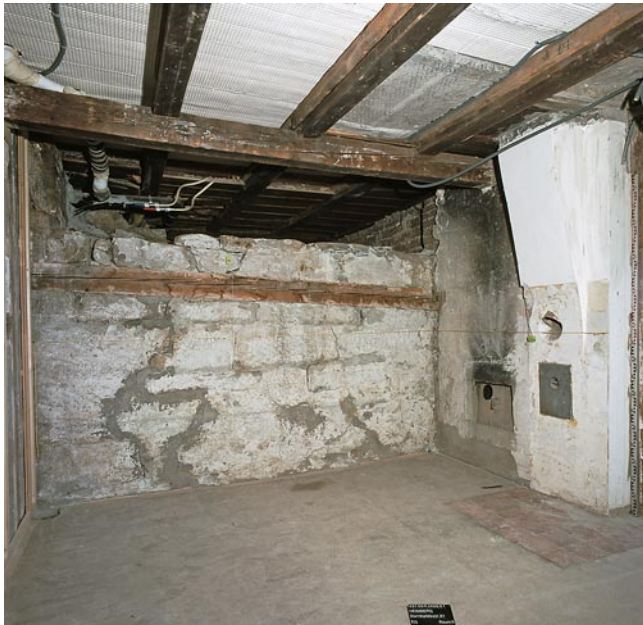
Abb. 13 Heimberg, Dornhaldestr. 31, 2006, Erdgeschoss. Ansicht des Brennofens von Westen.
