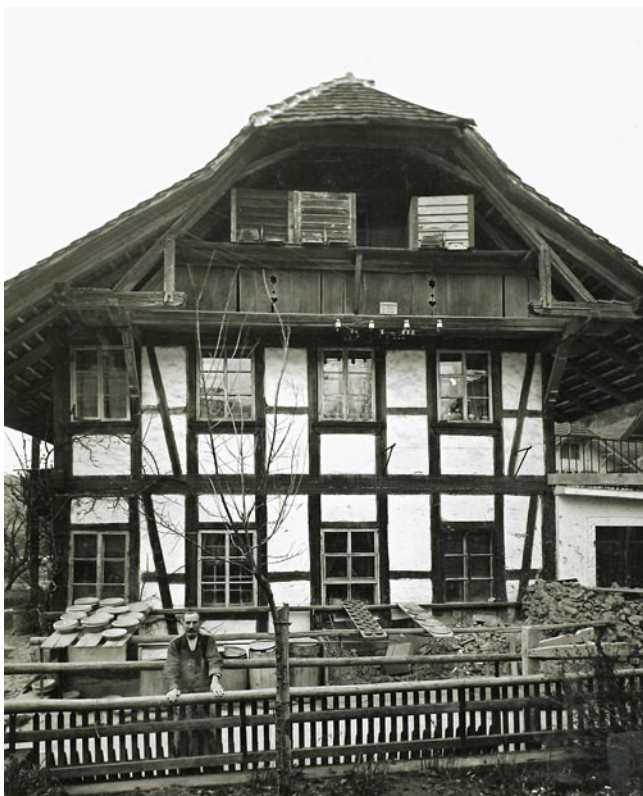
Abb. 3 Heimberg, Bahnhofstr. 4, Töpferei Hänni (heute abgebrochen). Vor den Werkstattfenstern der Südfassade befinden sich Trockengestelle für die frisch gedrehte Keramik.
