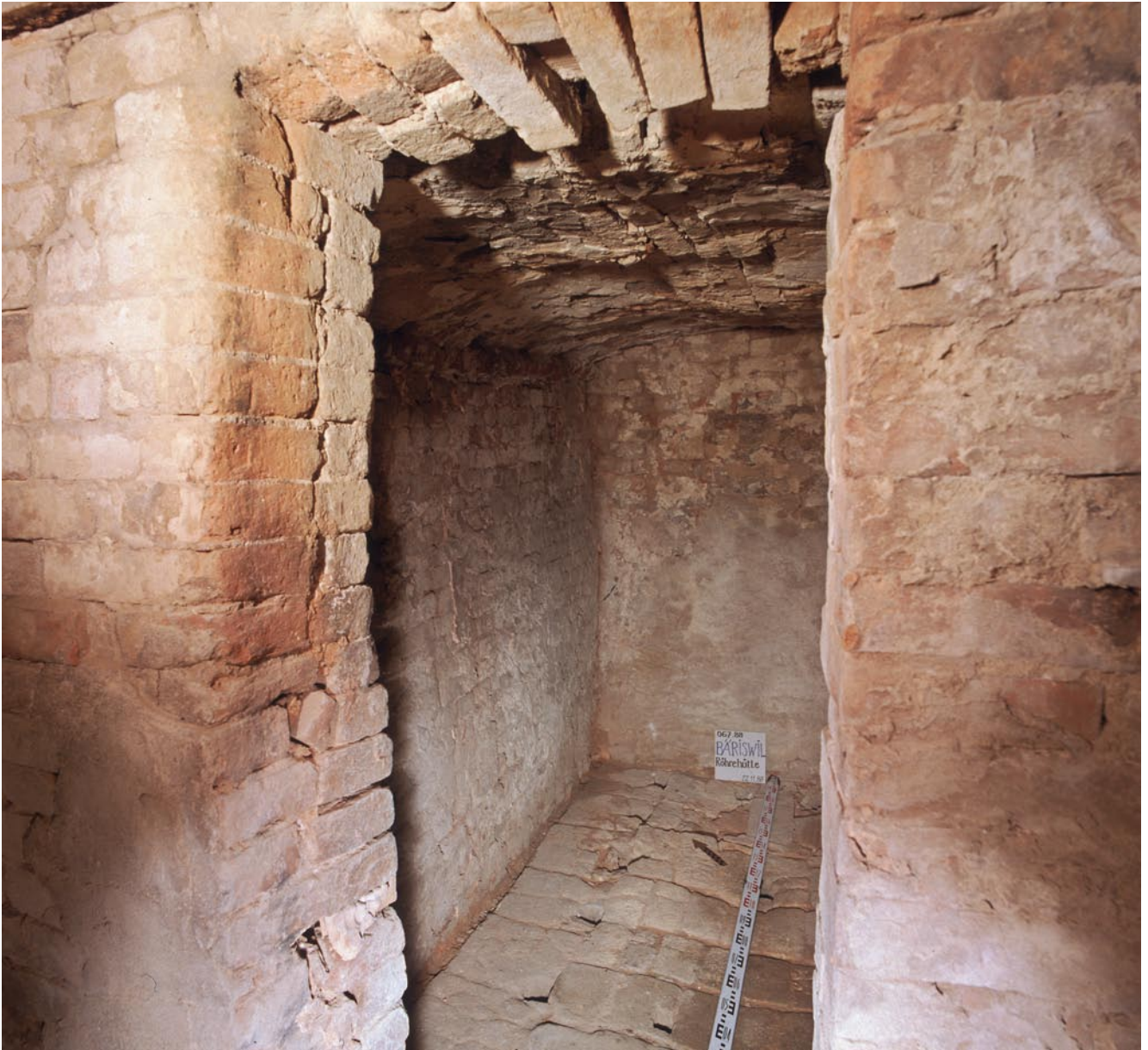
Abb. 36 Bärswil Röhrenhütte, Ofen C. Blick durch die Einsetztür in den Brennraum des Röhrenofens.
