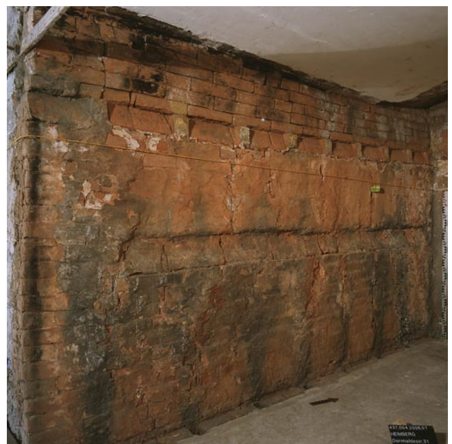
Abb. 15 Heimberg, Dornhaldestr. 31, 2006. Ansicht der Westwand des Brennraumes mit Ansatz des Zwischengewölbes, Nut für die Einsetzhilfen und Schmauchspuren über den Zuglöchern.
