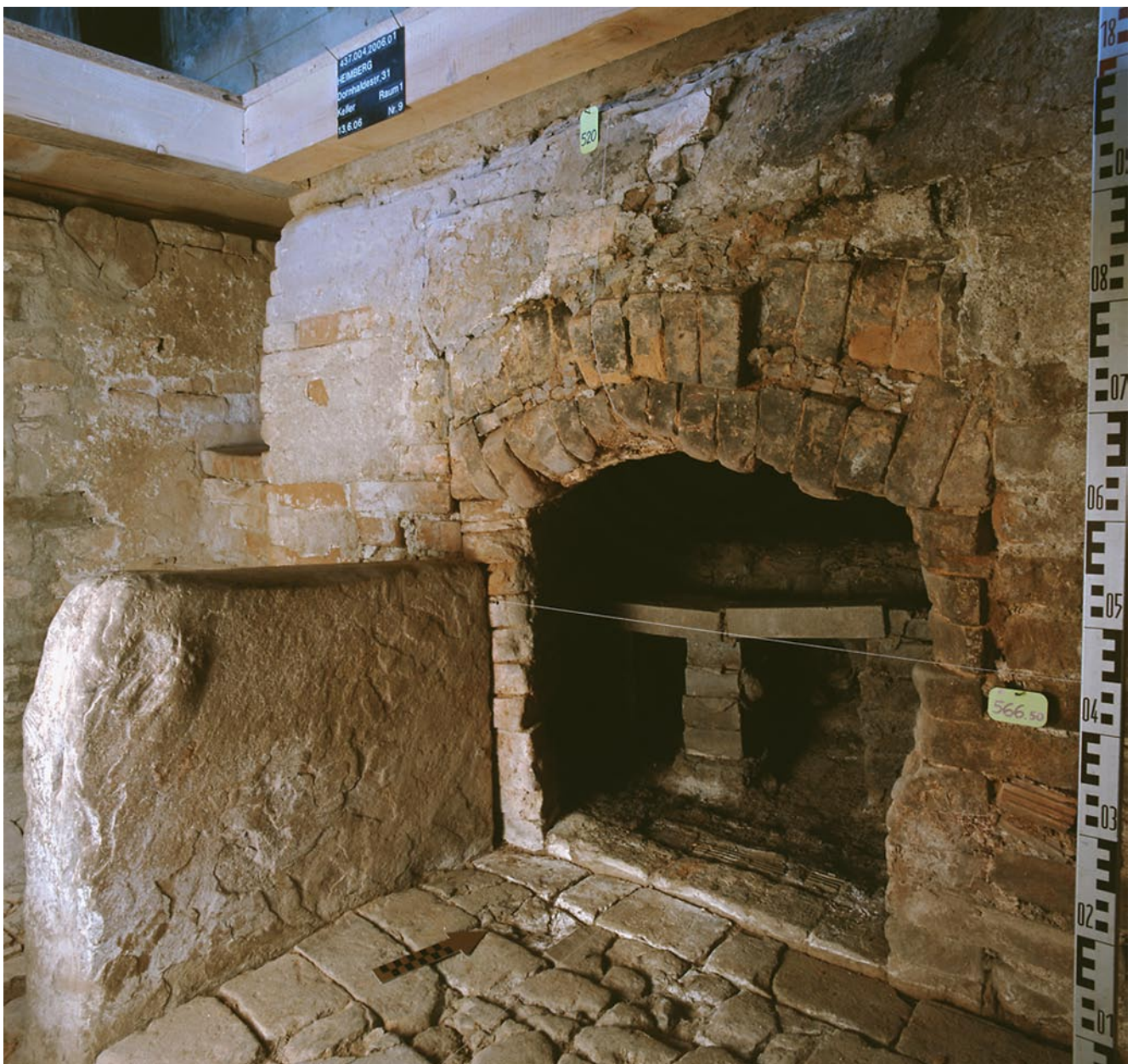
Abb. 16 Heimberg, Dornhaldestr. 31, 2006. Ansicht des Feuerungsraumes von Süden. Links der Hitzeschutz-Stein, dahinter der Treppenaufgang in die Werkstatt. In der Schürmündung der Rest des aus Backsteinen errichteten Rostes.
