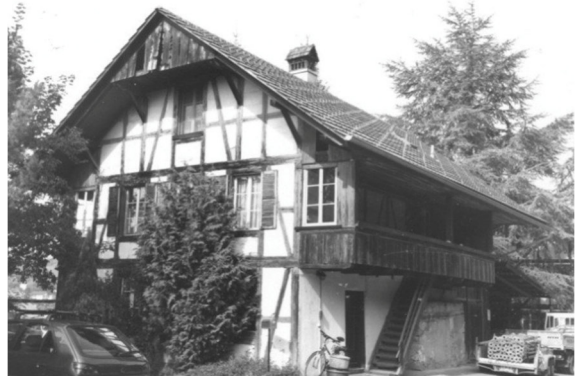
Heimberg Dornhaldestrasse 31 Bauinventar online
